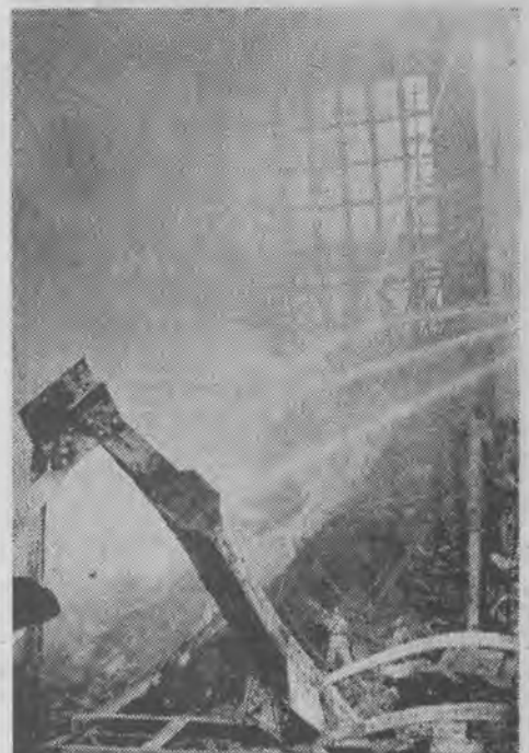
Wnętrze płonącego dworca. Stalowe belkowania gięły się jak zapalki
