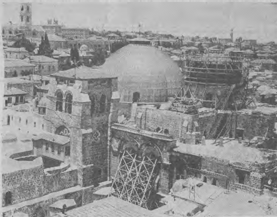
Kościół Zbawiciela w Jerozolimie, w którym mieści się grób Chrystusa. Trzęsienie ziemi w r. 1937 poważnie osłabiło mury i kopułę świątyni, tak, że musiało je zabezpieczyć specjalnymi rusztowaniami. Pielgrzymi zwiedzają świątynię na własną odpowiedzialność, niebezpieczeństwo bowiem zawałenia się murów nie zostało jeszcze całkowicie usunięte.
