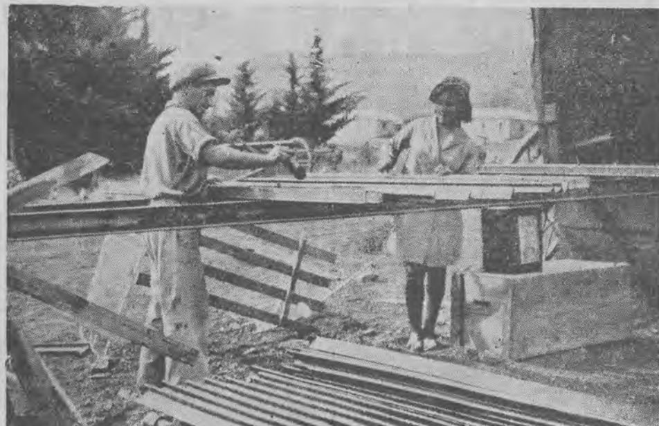
Osadnik żydowski z żoną — oboje emigranci amerykańscy — własnymi siłami wznoszą domek mieszkalny na fermie w północnej części Palestyny.
