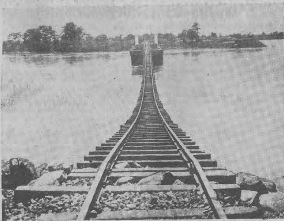
TOR KOLEJOWY ZAWISŁ W POWIETRZU Wskutek ulewnych deszczów wezbrane wody rzeki podmyły koło Kalkuty w Indiach tor kolejowy, który dostawnie zawisł w powietrzu
