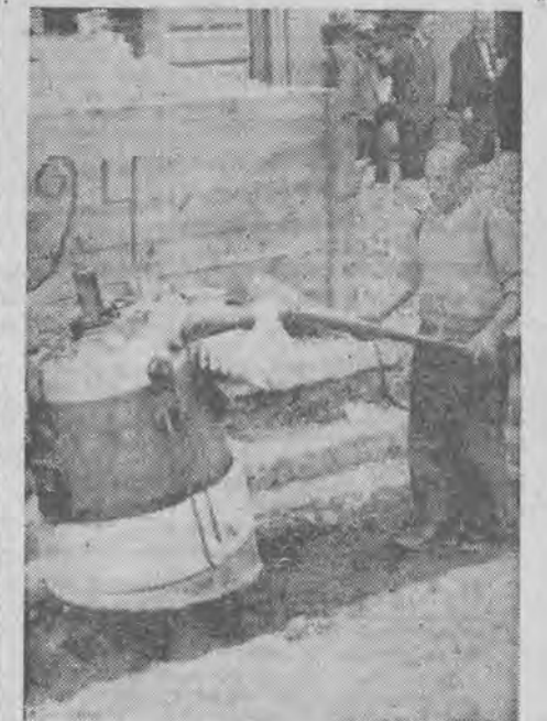
Automatyczny ubijacz ziemi stosowany przy budowie nawierzchni na ul. Piotrkowskiej. Ubijacz ten nabyty ostatnio przez Zarząd Miejski kosztował 10 tys. zł.
