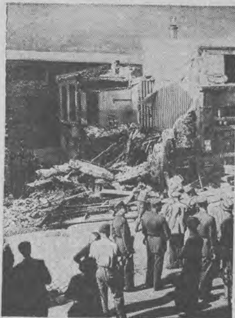
Katastrofa budowlana, jaka zdarzyła się ostatnio w Paryżu na ul. Choppe, spowodowała śmierć jednej osoby, przywalonej gruzami.
