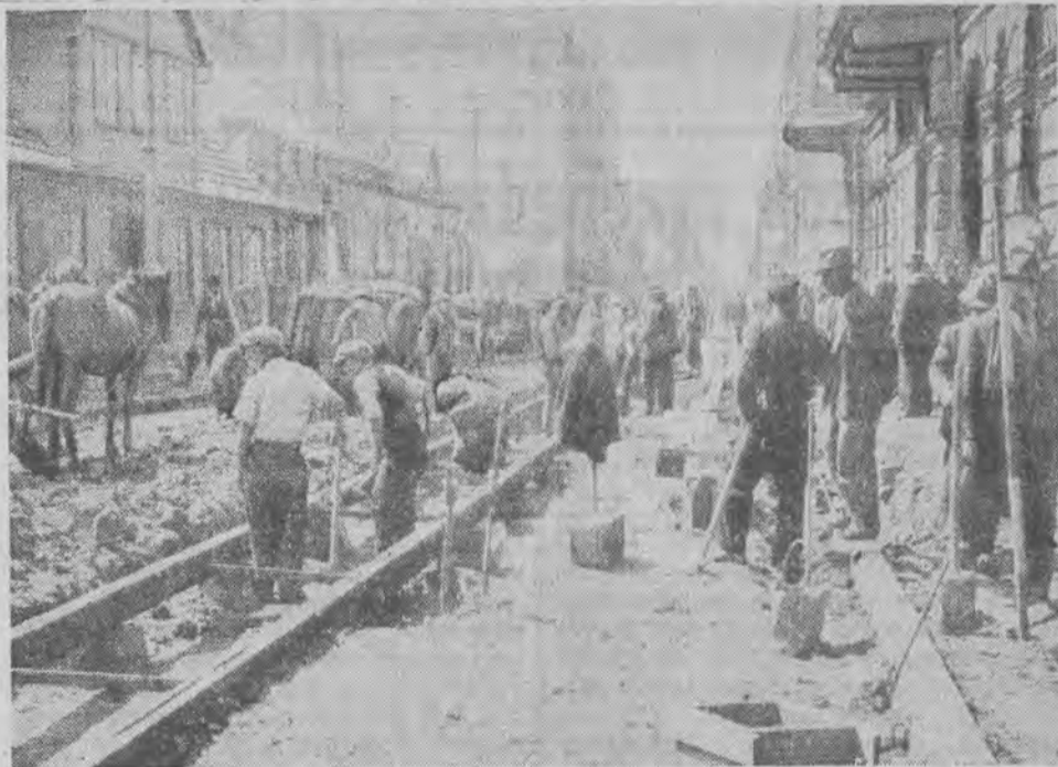
Prace drogowe na ul. Andrzeja
