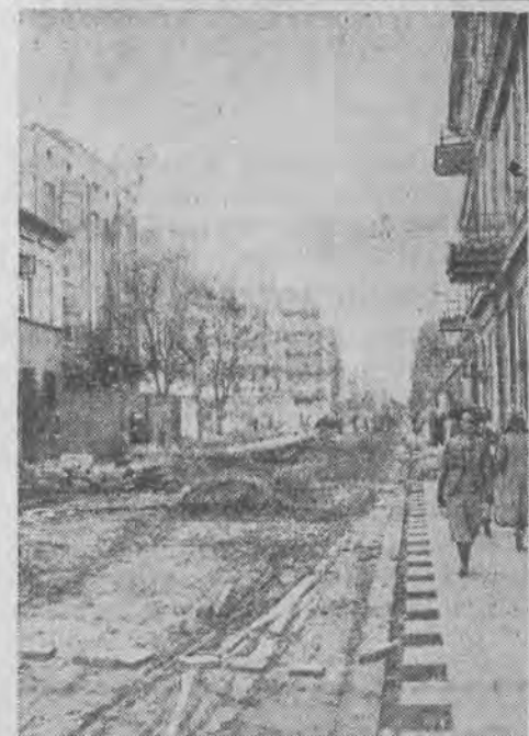
Na ul. Bandurskiego przeprowadza się roboty drogowe
