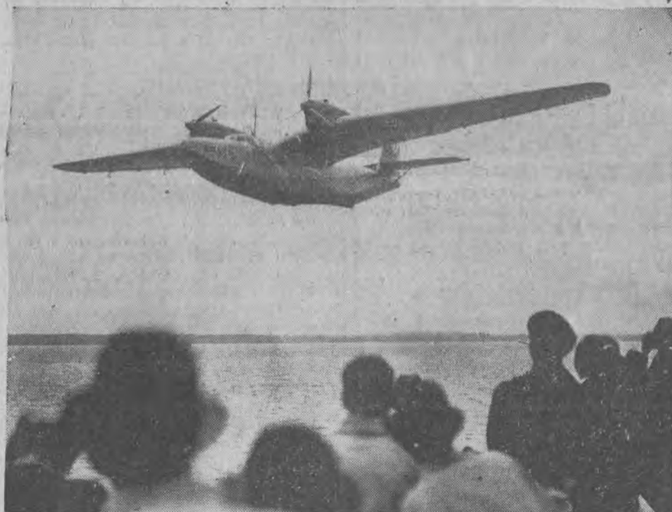
Startujący do lotu próbnego ponad Berlinem „DO 26”, nowy typ samolotu, przeznaczony do stałej komunikacji po czołowej na przestrzeni Lizbona — Nowy Jork. Samolot zaopatrzony jest w 4 motory, a ma zasięg 9.000 km przy szybkości maksymalnej 335 km/godz.
