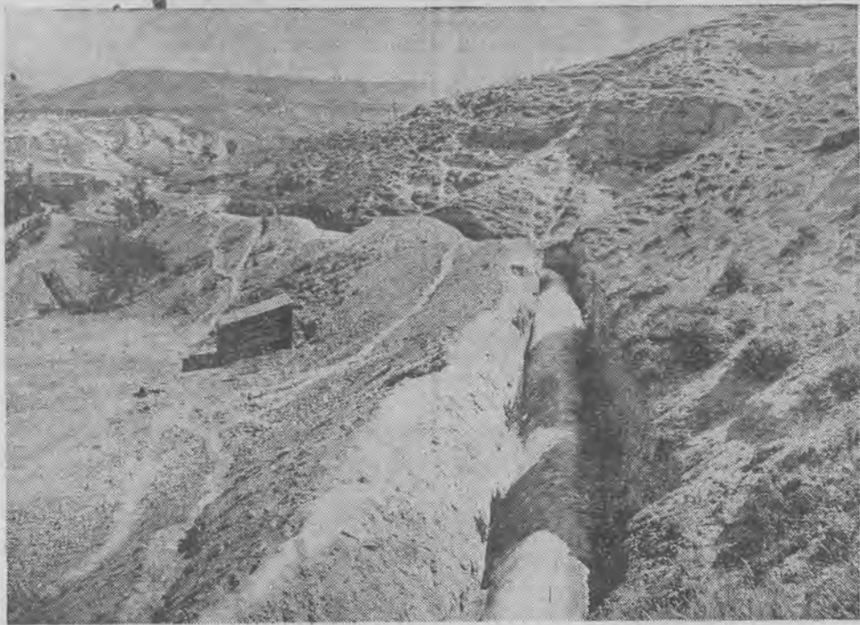
SIEĆ RUR I KANAŁÓW nawadnia spalone słońcem pustkowie górskie
