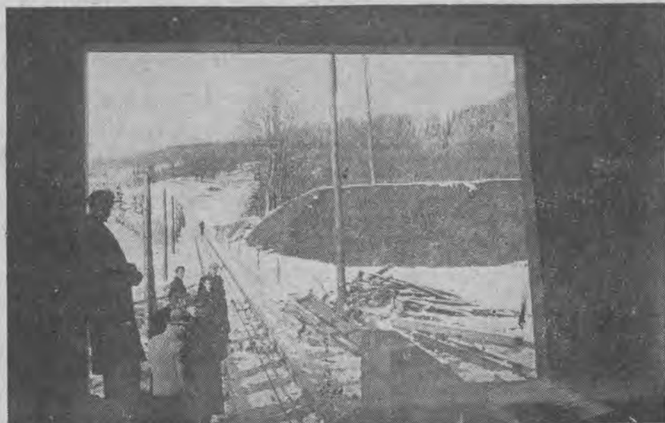
Widok z peronu stacji wyjazdowej na tor górskiej kolejki na Gubałówkę. Między torami widoczna jest stalowa lina, służąca do wciągania wagoniku na Gubałówkę
