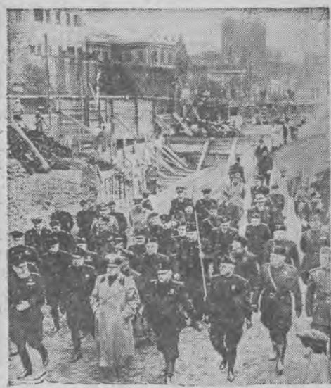
RZYM BUDUJE NOWE DWORCE Do roku 1942, kiedy to w Rzymie odbędzie się wystawa światowa, wykończone mają być nowe dworce w Rzymie. W tych dniach Mussolini dokonał osobiście inspekcji robót
