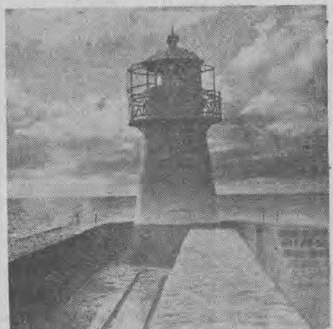
LATARNIA NA MOŁO PÓLNOCNYM u wejścia do portu w Kłajpedzie
