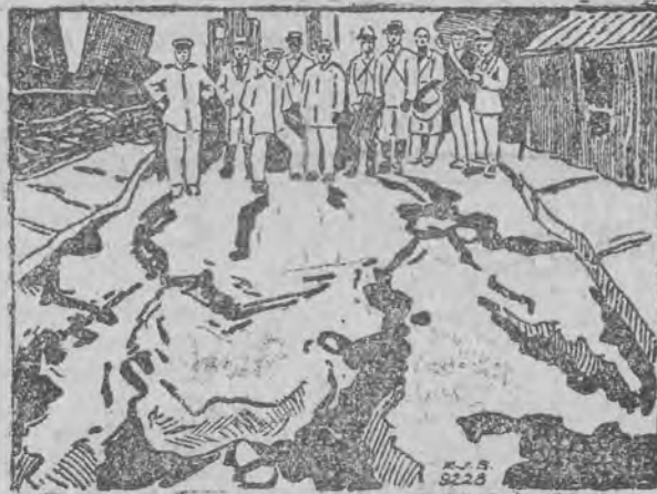
Wyrwy w bruku ulicznym w Yokohamie, powstałe po trzęsieniu ziemi.
