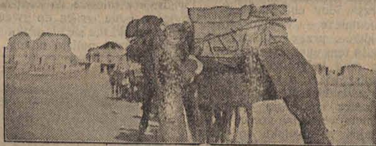
Transportowanie piasku z nad brzegu morza pod budowę w Tel-Awiiwie.
