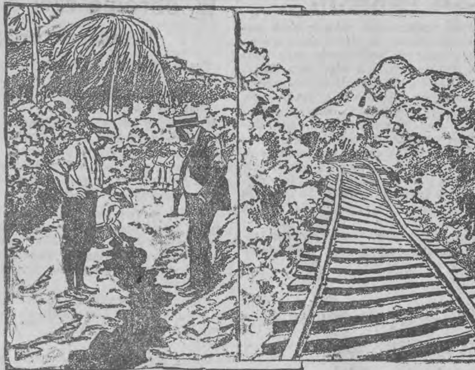
Uszkodzona linja kolejowa i ulica przecięta wyrwą, powstałą wskutek katastrofy.
