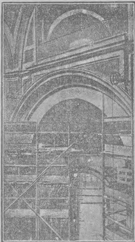
Prace reparacyjne w iondyńskiej katedrze św. Pawła, które mają uratować kopułę od zagłady.
