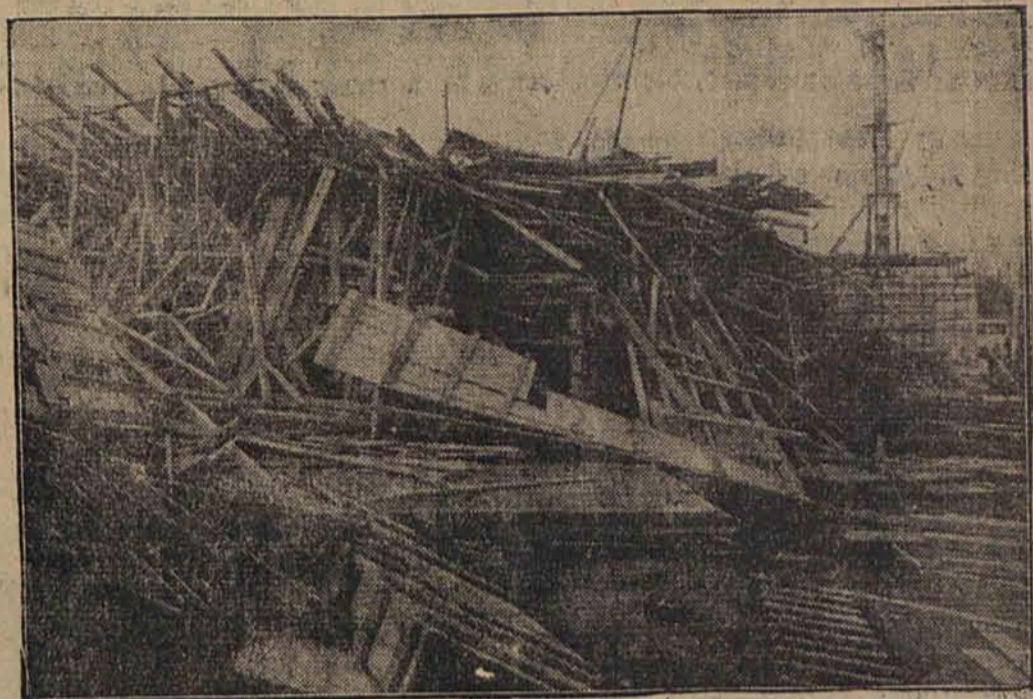
Shalejący w ostatnim dniu ubiegłego roku nad zachodnimi Niemcami orkan wyrządził w wielu miejscowościach olbrzymie szkody. Pomiędzy inn. w Dortmundzie runął prawie już ukończony kościół, powalony przez wściekły wicher. Na zdjęciu: ruiny budowli oraz rusztowania drewnianego, które ją otaczało.
