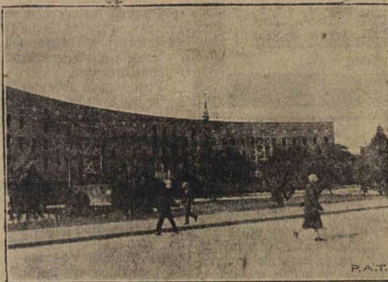
Imponujący gmach szpitala „Przemienienia Pańskiego” przy ul. Zygmuntowskiej w Warszawie, który ukończony będzie i oddany do użytku jeszcze w roku bieżącym.
