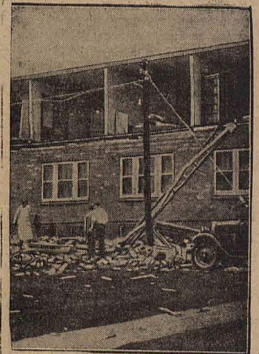
Dom na przedmieściu w Neapolu, którego zawalenie się na górnym piętrze spowodowało śmierć 8 osób. Pozatem 7 osób odniosło ciężkie rany.
