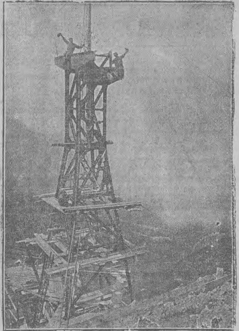
Roboty około napowietrznej kolejki na wierzchołek Zugspitze są na ukończeniu. Fotografia nasza przedstawia jeden z najwyższych filarów.
