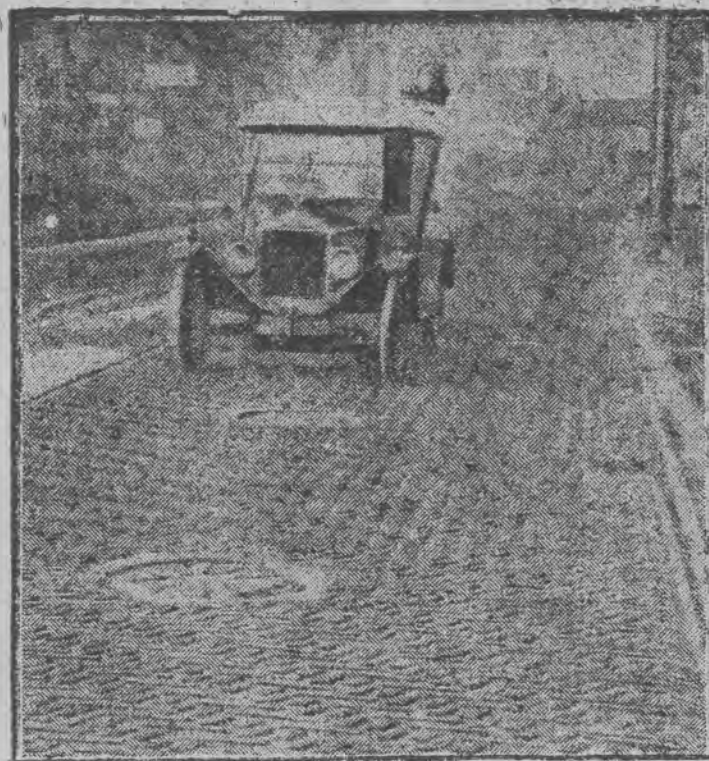
W Londynie wybrufowano specjalnie na jednej z ulic połowę jezdni drewnianymi kostkami i gumą, aby zbadać ślizganie się samochodów na zakrętach podczas deszczów i mrozów.
