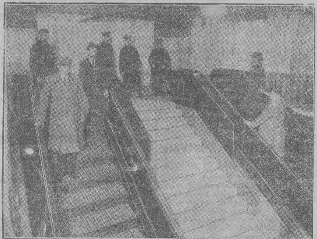
Na berlińskiej kolei podziemnej zaprowadzono ruchome schody.
