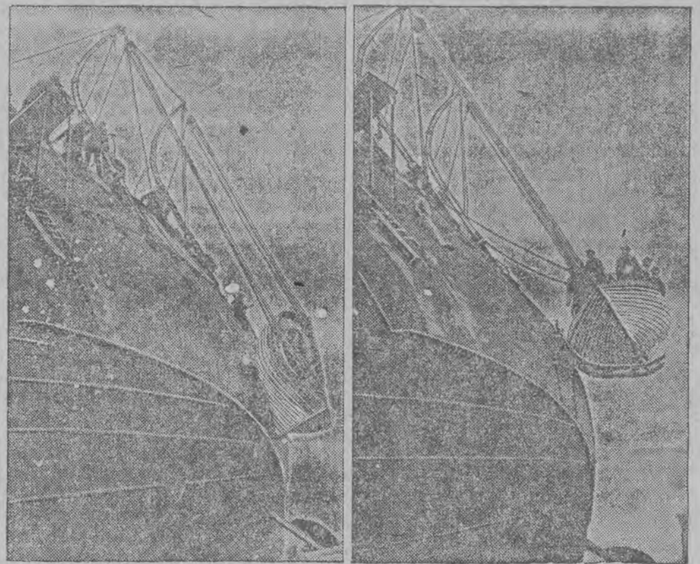
Międzynarodowe towarzystwo żeglugi w Gravenhage (Holandia) poraz pierw- szy zastosowało nowy wynalazek przy spuszczeniu łodzi ratunkowych ze swych okrętów. Praktyczność nowego wynalazku polega na tem, że łódź spada na po- wierzchnię morza dnem, a nie bokiem, jak to było dotychczas.
