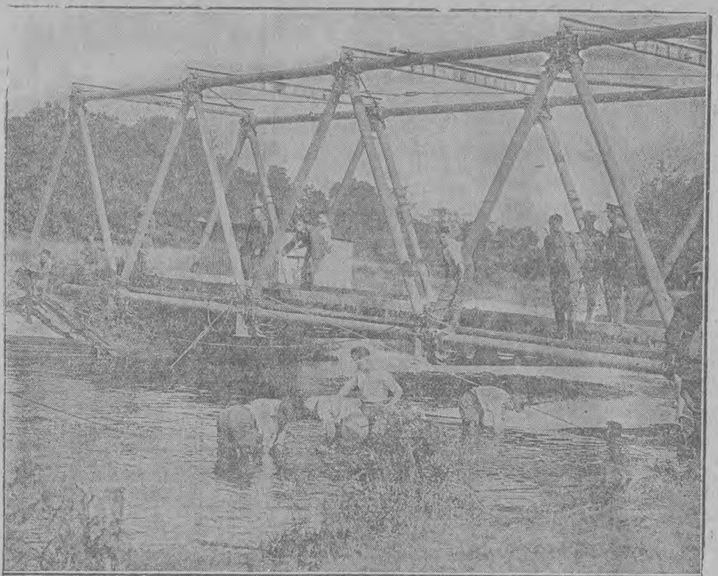
Podczas wojskowych ćwiczeń w Anglii saperzy w ciągu jednej godziny zbudowali most, przez który przeszło wojsko
