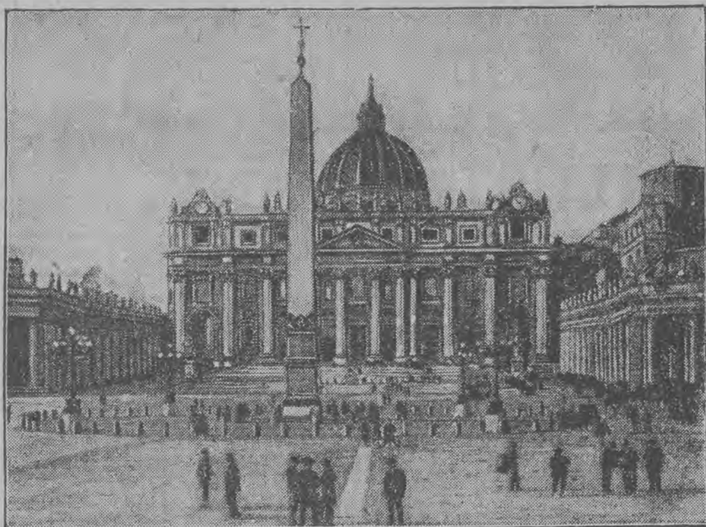
18 listopada 1626 roku ukończono w Rzymie budowę kościoła św. Piotra. Jest to jeden z największych i najpiękniejszych gmachów na kuli ziemskiej. Budowa jego trwała od r. 1506 do 1629.
