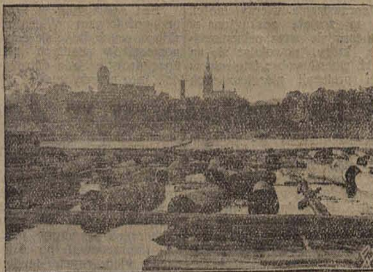
W letnich miesiącach splaw drzewa na Wiśle osiąga swoją maksymalną wysokość. — Rzeką płyną tratwy za tratwami. — Na zdjęciu naszym: 1) widzimy tratwy, mijające most kolejowy na Wiśle pod Toruniem. Na zdjęciu drugim widzimy na rzece potężne bale dębowe, splawiane do Gdańska.
