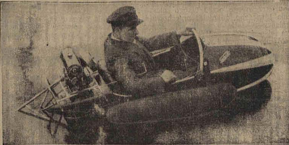
W Anglii skonstruowano specjalne motorki do przyczepki motocyklowych, które umożliwiają użycie tych wózków jako małych łódek motorowych.
