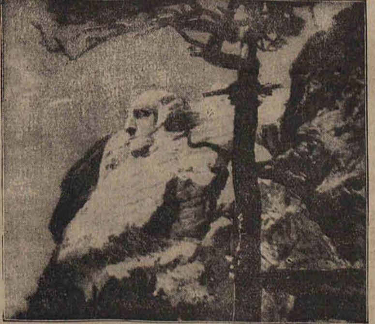
W południowej Dakocie (USA) wykańcza się obecnie głowę pierwszego prezydenta St. Zjednoczonych, Jerzego Waszyngtona, ciosana w skałę granitowej. Pracę tę wykonuje rzeźbiarz amerykański Gutzon Borglum.
