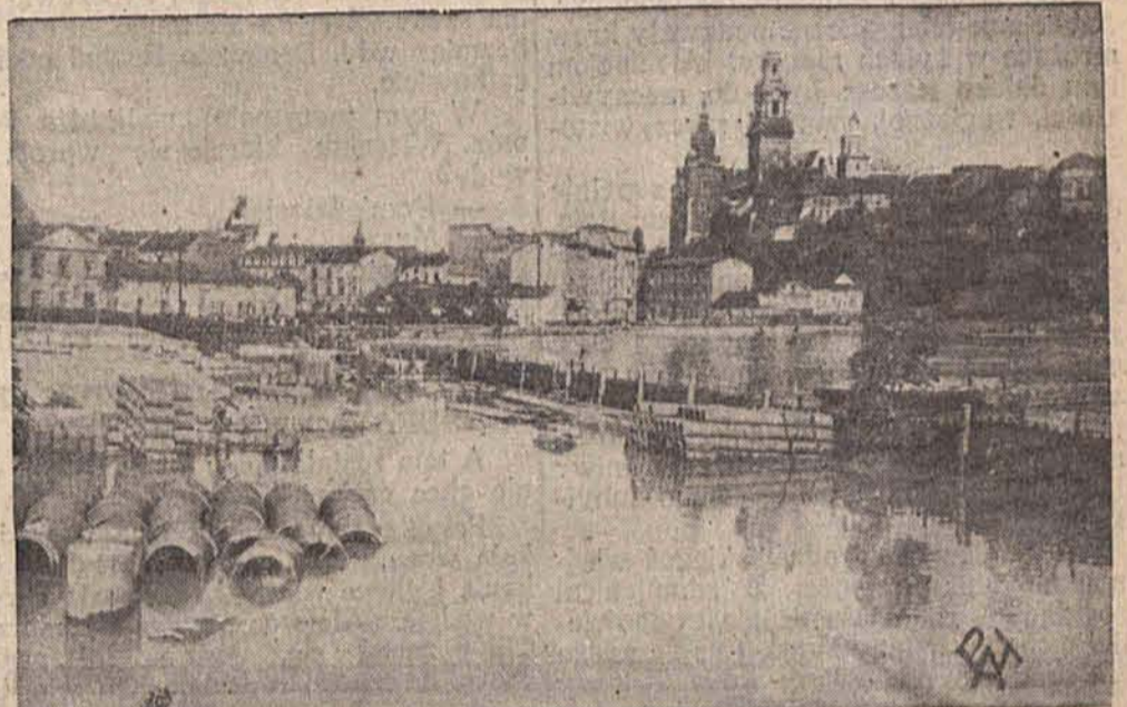
Powódź na Wiśle pod Krakowem. Widok na Podzamcze.
