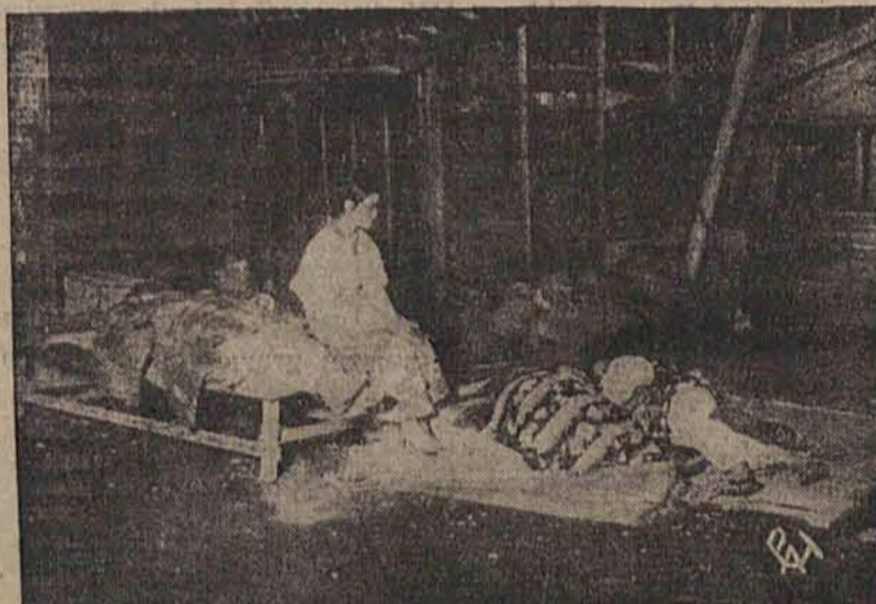
Młoda japońska z dziećmi na gruzach domu, w mieście Shizuoka, w którym po ostatnim trzęsieniu ziemi połowa ludności została bez dachu nad głową. Katastrofa pociągnęła za sobą kilkanaście ofiar śmiertelnych, a ponad 100 osób zostało ciężko rannych.
