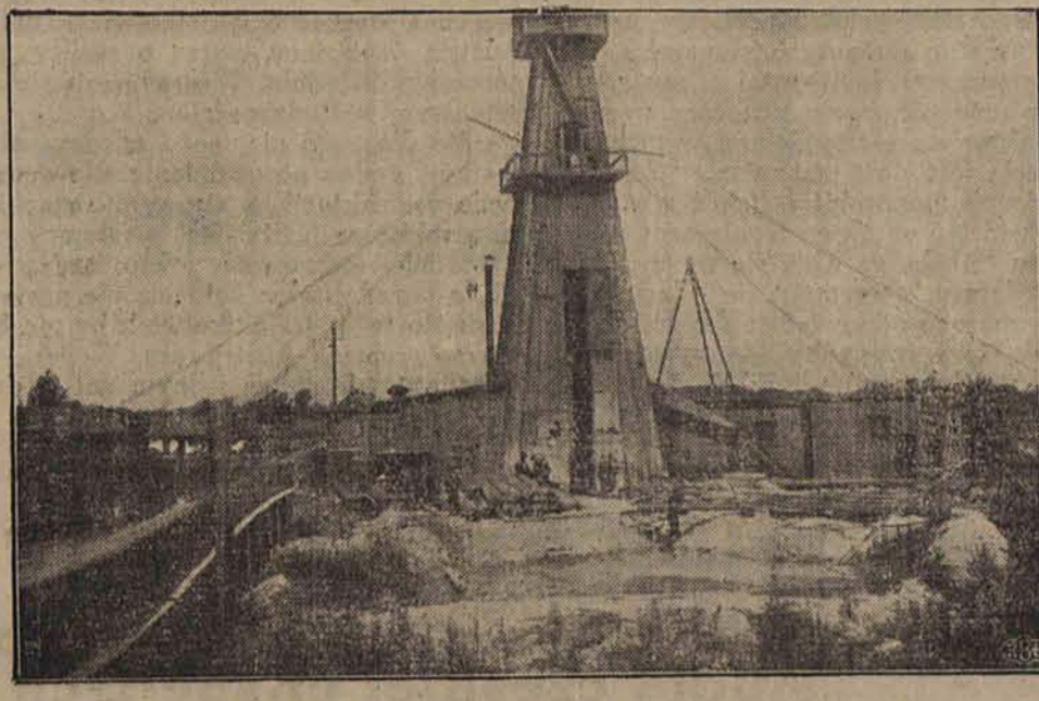
Pierwsza studnia, zbudowana przez wydział kanalizacji, która będzie dostarczać nam czystej i zdrowej wody.
