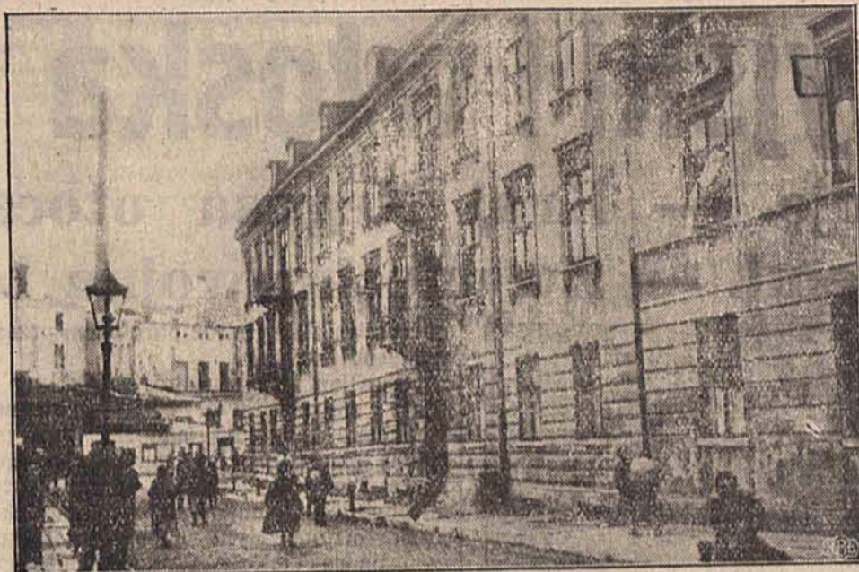
Dom przy ul. Solnej Nr. 11, który zostanie zburzony. — Wczoraj rozpoczęła się już ewakuacja mieszkańców.
