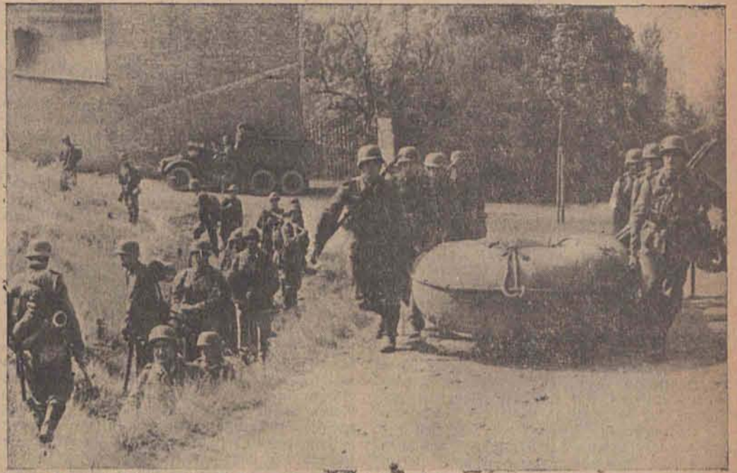
Gesprenzte Brücken konnten den Vormarsch nicht hindern
