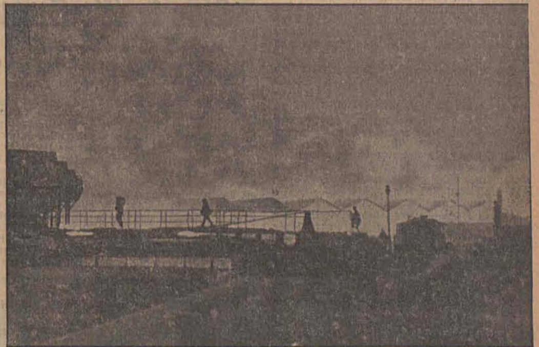
Die brennenden Lagerhäuser an der Themse Die Bekämpfung dieser Brände ist eines der wichtigsten Probleme in der Verteidigung der britischen Hauptstadt.
