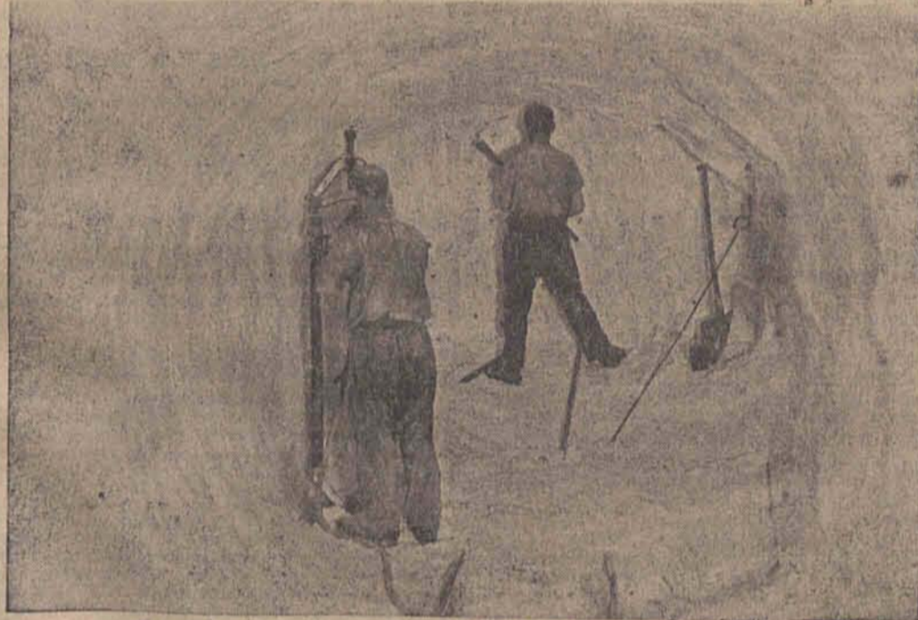
Der Salzmauer wird mit dem elektrischen Bohrer zu Leibe gerufen
