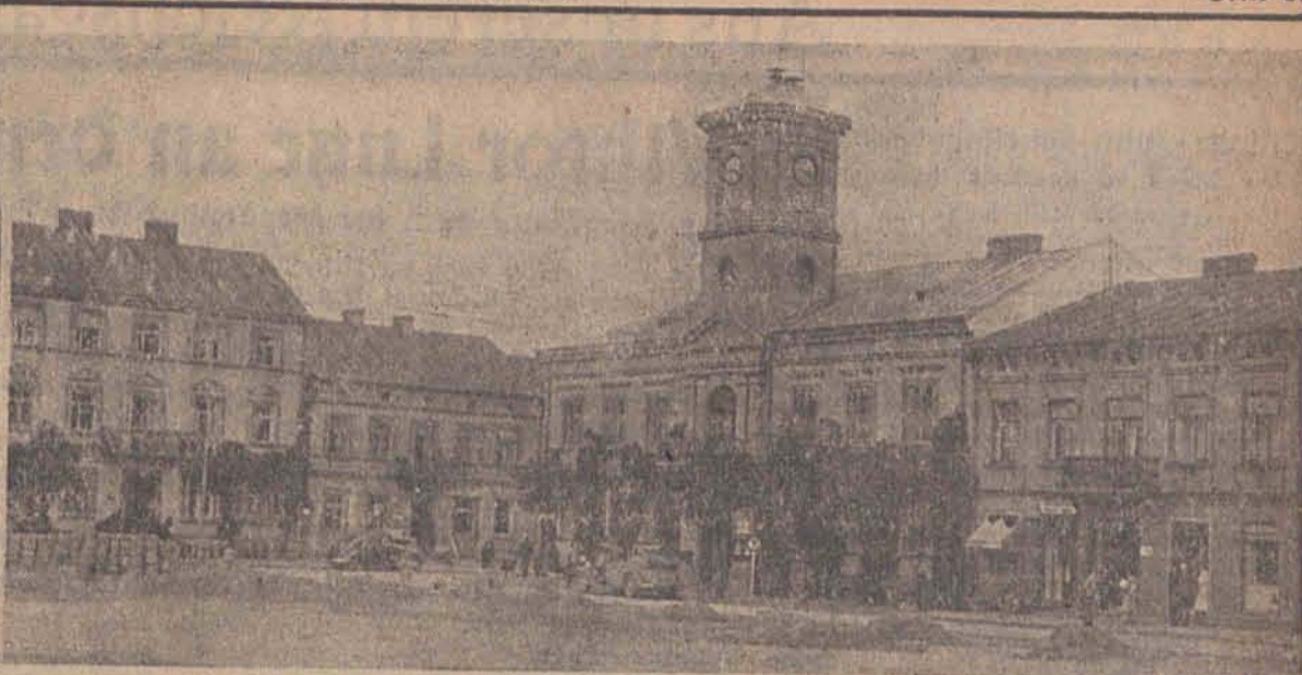
Bauarbeiten am Markt
