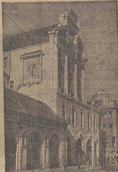
Die Fassade der Stadtsparkasse Aufnahmen (4): W. Klawnski
