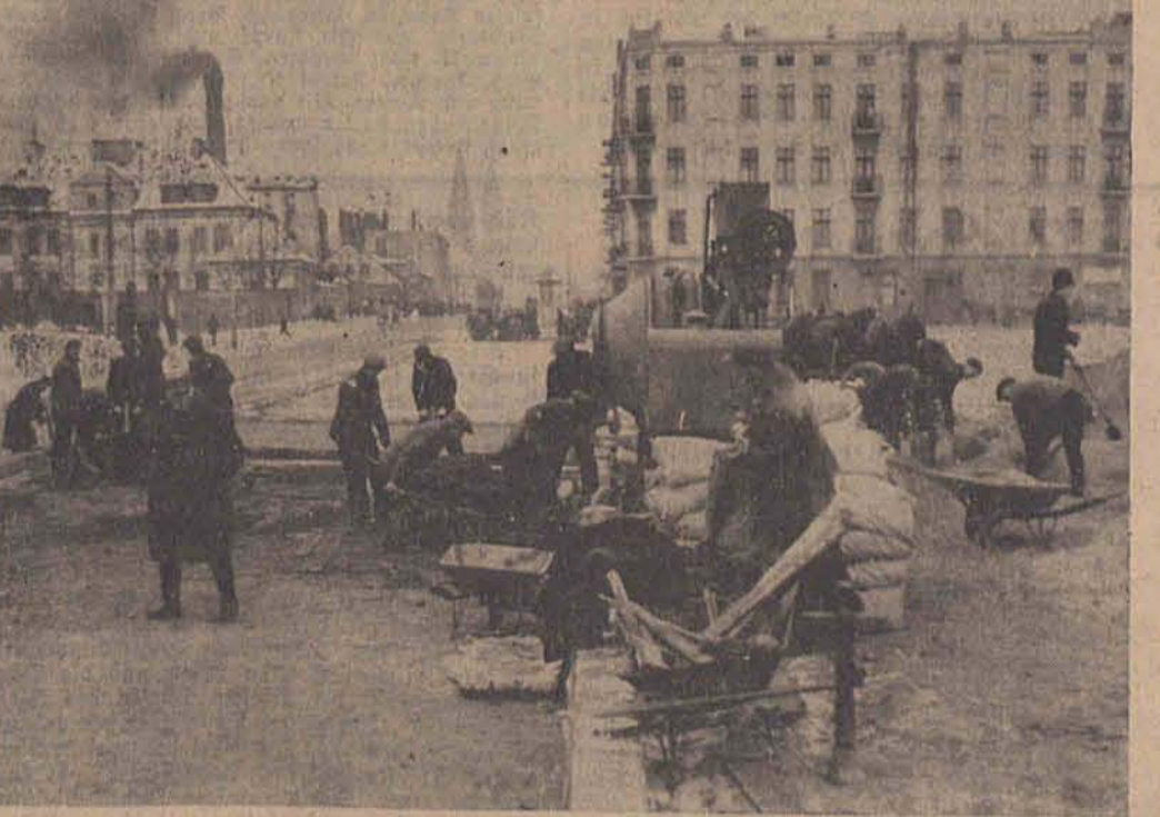
Straßenbauarbeiten am Freizeiplatz in Litzmannstadt. (Aufnahme: Jastrow)
