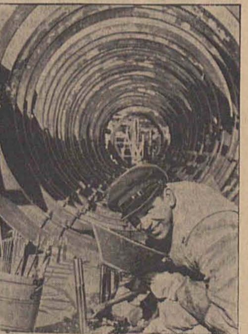
Auf allen deutschen U-Boot-Werften herrscht Hochbetrieb. Am Druckkörper des Unterseebootes gibt es für den Schweißler viel Arbeit. Aber wie man sieht, leistet er sie sachverständig und vergnügt. (Atlantic, Submann, Zander-Multiplex-K.)
