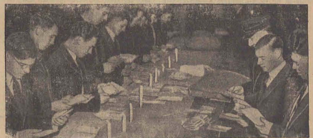
Bei Kerzenlicht im Keller verrichten Beamte eines englischen Postbüros ihre Arbeiten, da die Postanstalt zerstört ist. (Presse-Hoffmann, Zander-Multiplex-K.)
