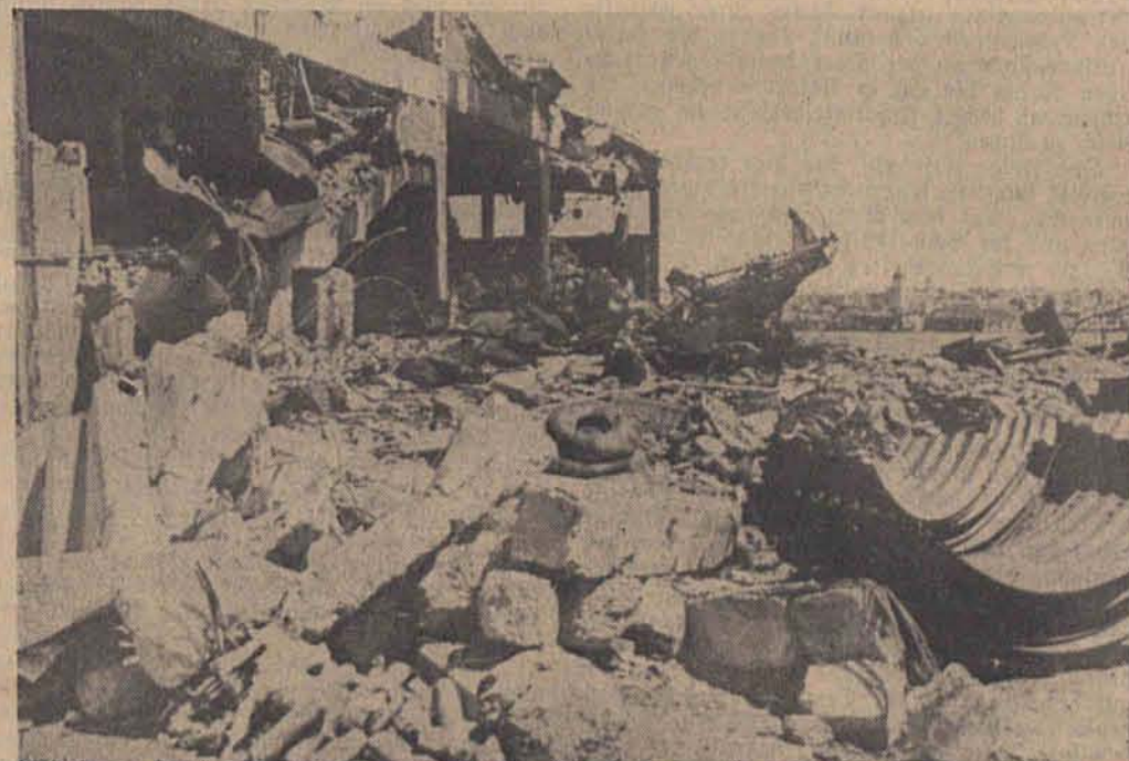
Die Wirkungen der deutschen Stuka-Angriffe auf die Hafenanlagen von Piräus! (PK. Baier, Presse-Hoffmann)
