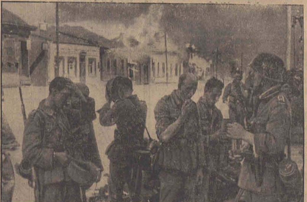
Sie waren die ersten in Miteß Kradschützen, die als erste in das brennende Miteß an der Düna eingedrungen waren. (P.R. Jacobsen, Presse-Hoffmann, Zander-M.K.)
