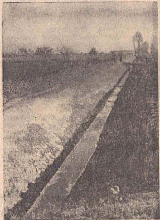
Ein Vorflutgraben wie er sein soll
