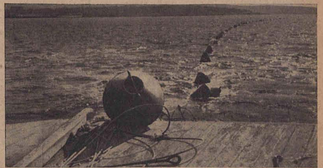
Netzsperrn schützen griechische Häfen vor englischen U-Boot-Angriffen. Reihenweise werden die Haltebojen, zusammen mit den gefährlichen „Netzen“ ausgeworfen. (PK.-Aufn.: Kriegsberichterstatter Ripken, PBZ, Z.)
