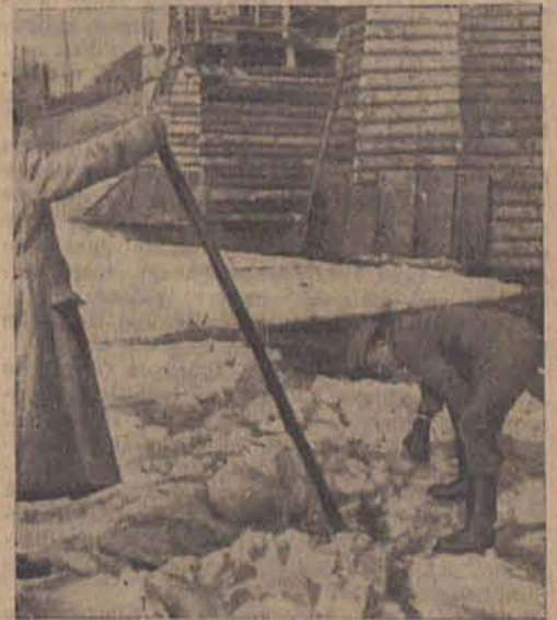
Treibels wird gesprengt
