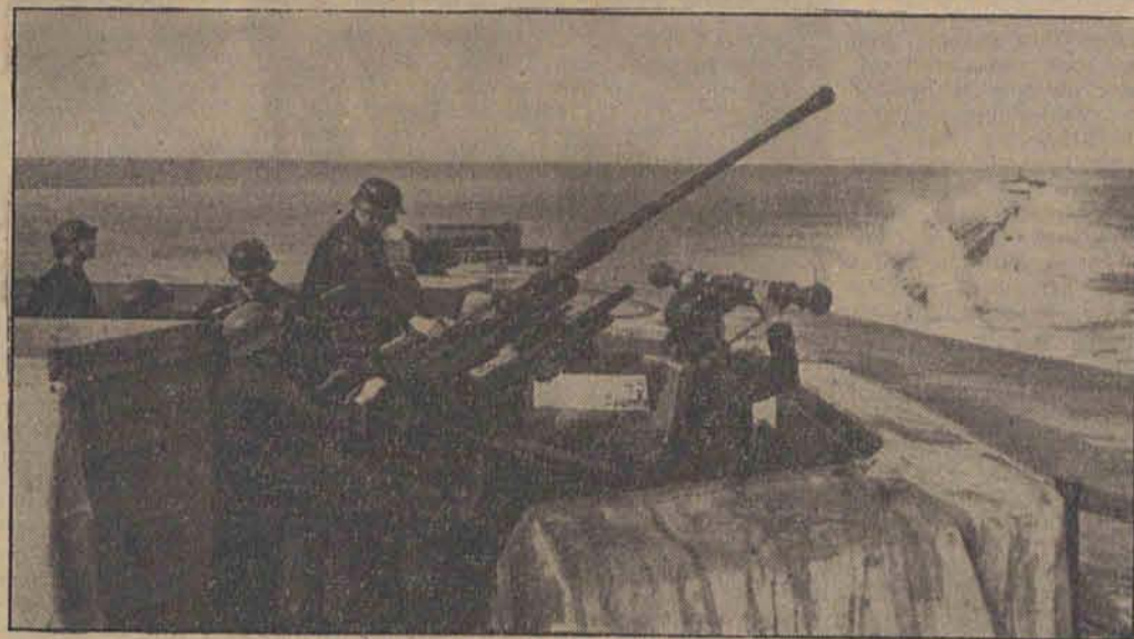
Die Kanalküste ist gesichert
