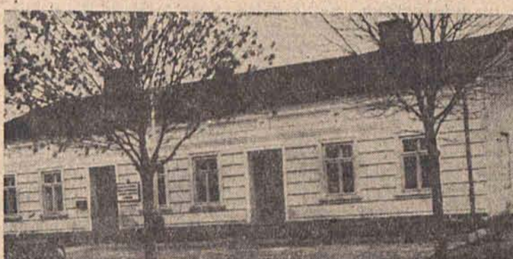
Das Gebäude der Amtsverwaltung
