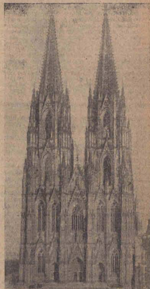
Das bedeutendste Bauwerk der Hochgotik, der Kölner Dom, wurde durch Terrorbomben schwer beschädigt. (Foto: LZ.-Archiv)
