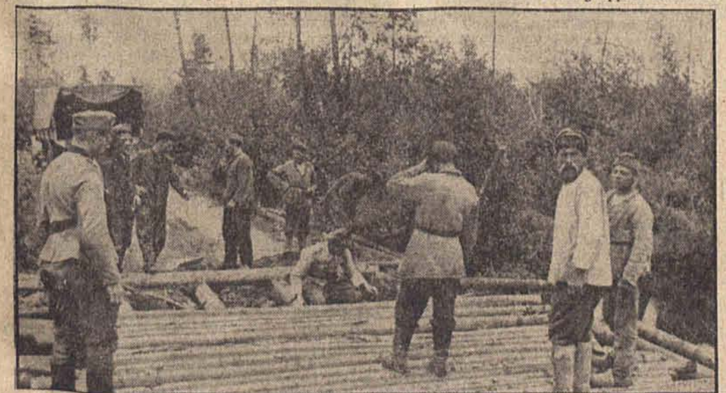
Meter um Meter rückt der Damm vor und dringt tief in den Sumpfwald ein, immer näher heran an die Kampffront, deren Versorgung mit Nachschubgütern aller Art durch ihn gewährleistet wird (PK.-Aufn.: Kriegsbericht Pospischil, HH., Z.)
