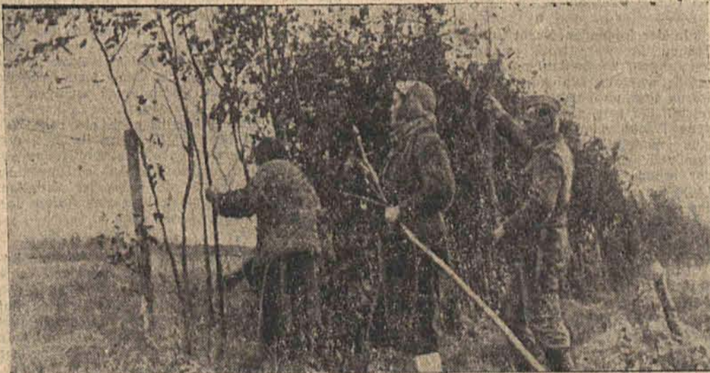
Schneezäune für die Rollbahnen Als Schutz gegen Schneeverwehungen und Feindeinsicht werden jetzt die Rollbahnen im Osten mit Blenden versehen. (PK.-Aufn.: Kriegsberichter Schürer, At., Z.)
