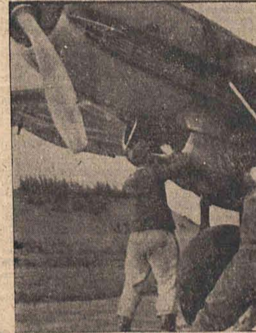
Vor dem Start gegen den Feind Mit der langen Kurbel wird der Motor angeworfen, wenn der elektrische Anlasser mal versagt (PK.-Aufn.: Kriegsberichterst. Sierstorff, Sch., Z.)
