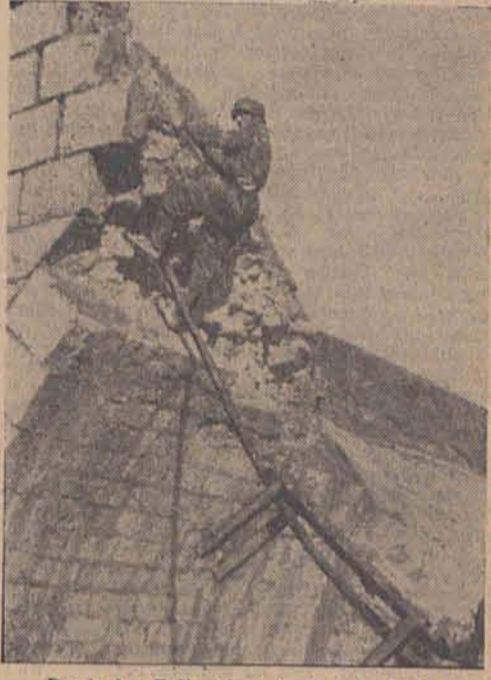
Deutsche Fallschirmjäger in Italien. Die für Sprengarbeiten eingesetzt sind. Die Reste eines übriggebliebenen Mauerbogens werden durch eine neue Sprengladung beseitigt (PK.-Aufn.: Kriegsbericht Wähler, PBZ., Z.)
