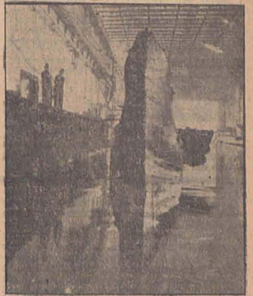
U-Boot-Reparatur unter Beton
